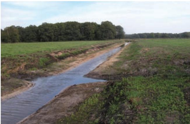
Abb. 7: Der fertige mit Doppeltrapezprofil angelegte Graben füllt sich allmählich mit Wasser. [Foto: Kausche]
