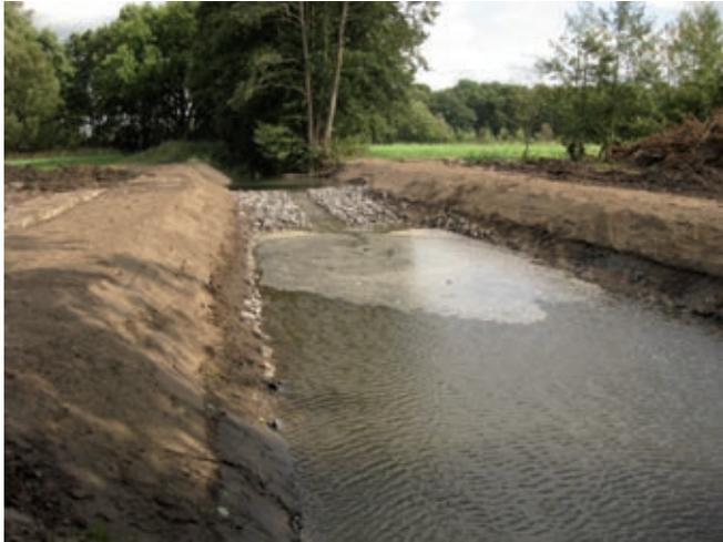
Abb. 9: Die Stützschwelle im Solpker Wiesengraben übernimmt nach Fertigstellung ihre Staufunktion. Gut zu erkennen ist die Niedrigwasserabflussrinne zur Herstellung der ganzjährigen Passierbarkeit für Fische und aquatische Kleinlebewesen. [Foto: Weber]
