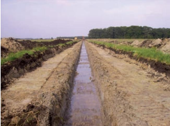
Abb. 6: Das untere und obere Rechteck des Grabenprofils sind fertiggestellt. Die Böschungsprofilierung folgt noch. [Foto: MEBAG]
